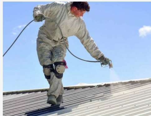
Pintura aislante acústica Viernes, 29 mayo, 2015 | Sin comentarios
